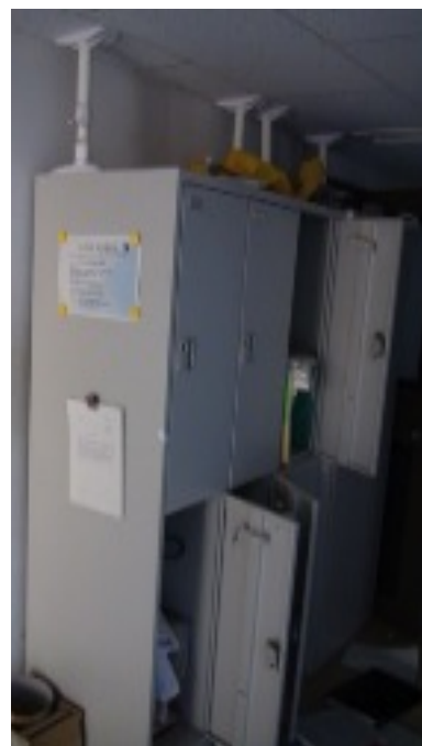
本震後の研究室。市販の家具転倒防止用品を設置していたおかげで通路が確保された。
