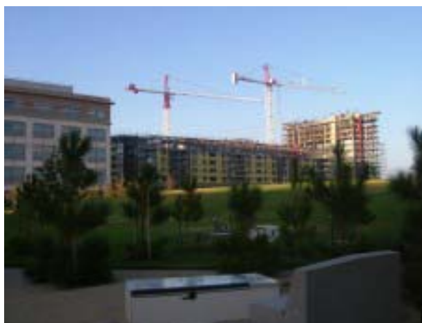
周りを見渡すと、工事中の建物がたくさんある。
