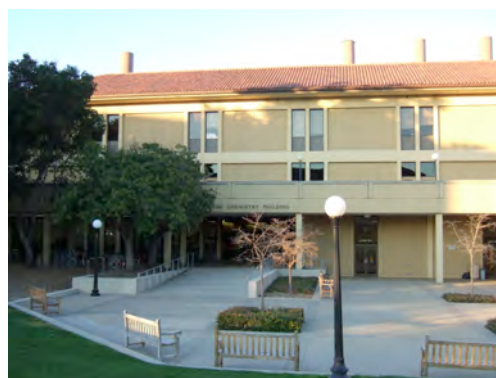
化学科の本部 Mudd Chemistry building (この前でよく BBQ パーティーが開かれています)
