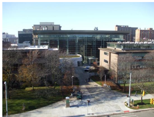
Wayne 州立大学化学科(写真中央)。手前の二つの建物は講義棟。右奥に見える2つの建物は Wayne 州立大学の学生寮。
